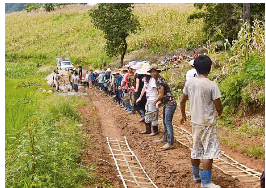
緊急車両通行のための簡易的な道をつくっている様子
