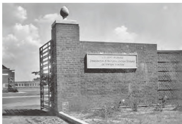
写真1 シーガビル収容所の入口の門
